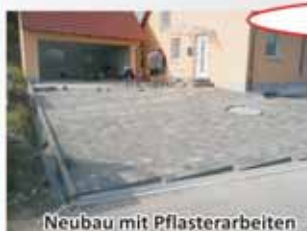
Neubau mit Pflasterarbeiten
